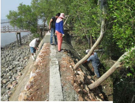
ก่อสร้างเสริมเขื่อนเพื่อ ป้องกันน้ำท่วม หมู่ที่ ๔ บริเวณบ้านนายทศพล พลไทรทอง
