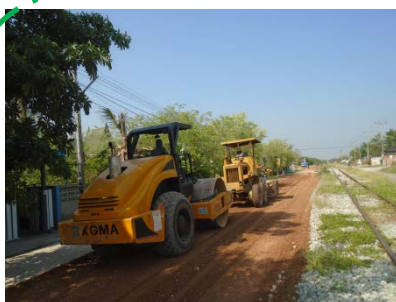
ก่อสร้างซ่อมเสริมถนนหินคลุกเข้าหมู่บ้าน เลียบคลองนิคม ๑ หมู่ที่ ๑
