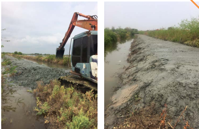
ขุดลอกกันคลองเลียบบทางรถไฟ หมู่ที่ ๒
