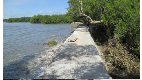
ก่อสร้างเสริมเขื่อนหินใหญ่ เพื่อป้องกันตลิ่งพัง หมู่ที่ ๔ บริเวณ บ้านนางฉลอง ครสง ถึงบ้านนายยัง เตชะไพศาลทวี
