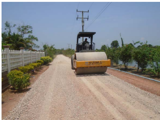
ก่อสร้างซ่อมเสริมถนนหินคลุกเข้าหมู่บ้าน เลียบคลองนิคม ๑ หมู่ที่ ๑
