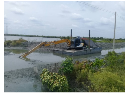
ขุดลอกคลองนิคม ๒ หมู่ที่ ๒
