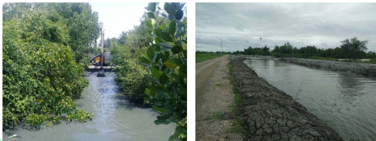
ขุดลอกคลองนิคม ๑ หมู่ที่ ๒
